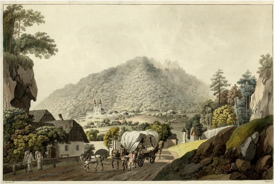
Abbildung 2: Auf der „alten“ Semmeringstraße (vor dem Neubau 1842) bewegt sich ein schwer beladenes Fuhrwerk mit Vorspann Richtung Passhöhe. An den Hinterrädern sind die auf den Gefälleabschnitten der Straße wichtigen Bremskufen zu erkennen.
